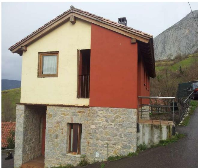
Se trata de una vivienda unifamiliar aislada de dos alturas, cerramiento exterior de piedra y enfoscado de mortero y pintado en primera planta, cubierta a dos aguas, cobertura teja curva tradicional, no dispone de canalones en los aleros que recojan y canalicen el agua de lluvia. Las carpinterías son de madera con contraventana también de madera y herrajes metálicos, vierteaguas exterior de acero. Alero revestido con lamas de madera.
